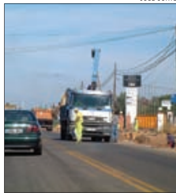
Obras de la Ex-300.
